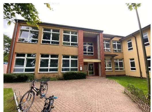
Abbildung 29: Gemeindebüro mit Bekanntmachungskasten Quelle: inspektour GmbH 2026
